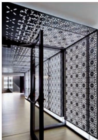
Figura 5.9. Paneles realizados mediante cortadora láser
